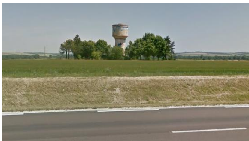
FIGURE 9 : PHOTOGRAPHIE DU RESERVOIR DE ST-LYE A REHABILITER (GOOGLE MAPS)
