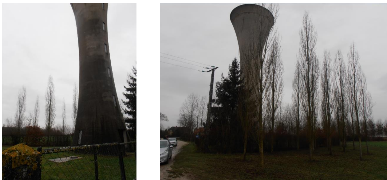
FIGURE 6 : PHOTOS DU RESERVOIR DE ST-OULPH A REHABILITER (28/01/2016)
